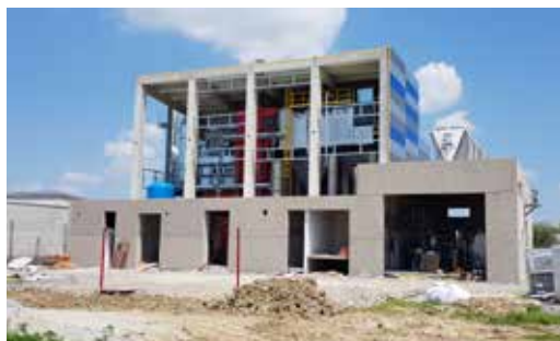
Lavori in corso nel cantiere a Bjelovar
